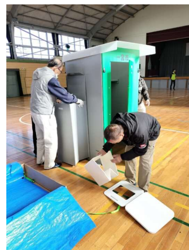
簡易組立式トイレ組立
