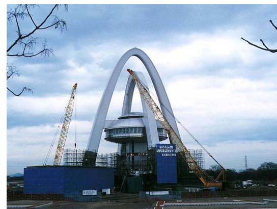
30年前の建設風景
