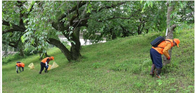
堤防斜面での「ツル切除」作業風景。熱中症に気を付けて！
