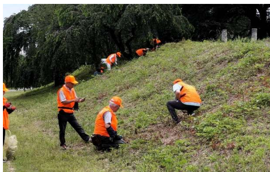
堤防斜面での作業風景
